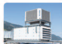
Modernizálás, HVAC retrofit
