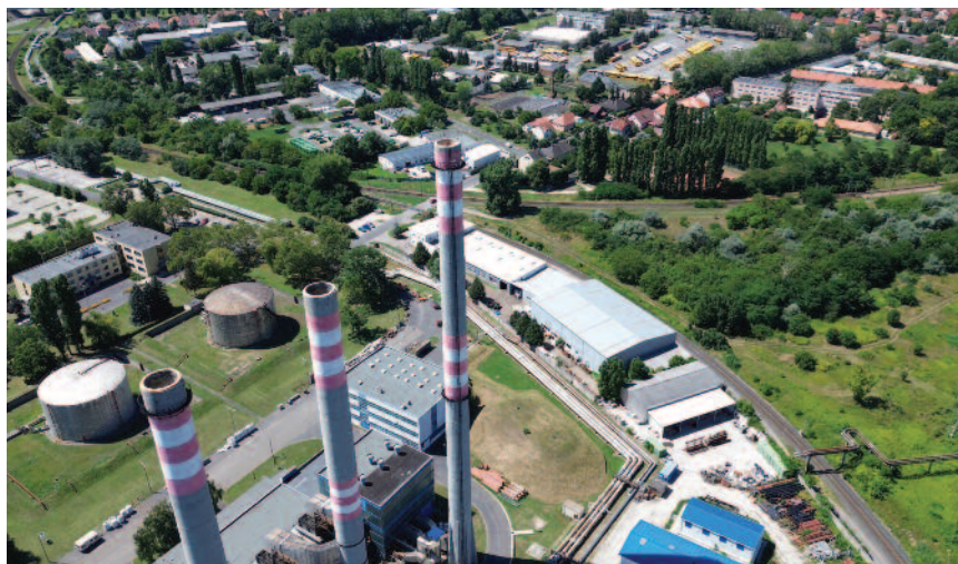
A Rozgonyi úti telephely látképe a tartályokkal, a forró vizes kazánházzal és a távhőellátási vezetékek iránytorésétől jobbra látható (négy szellőzőablakkal és kék tetővel rendelkező) geotermikus hőtároló állomással
