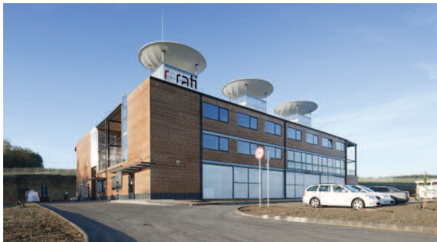
1. kép – Az épület külső megjelenése
