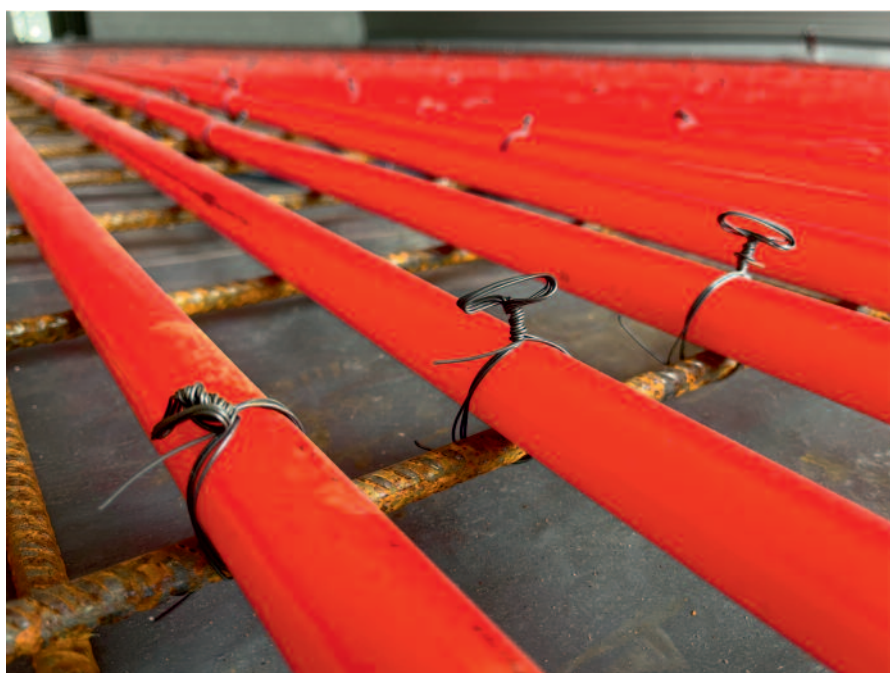
Kötések pillanatok alatt: egy jégpálya felülethűtési csöveinek rögzítésére 2 nap is elég
