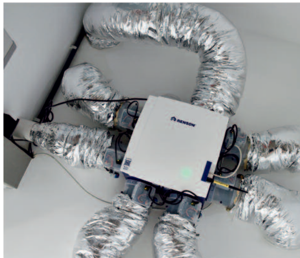
Renson központi szellőztető gép: Healthbox 3.0
