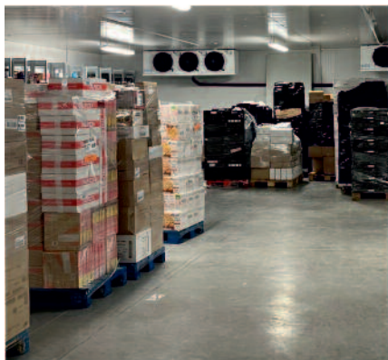
A földszinti hűtőház bővítése egy Kelvin elpárologtatóval
