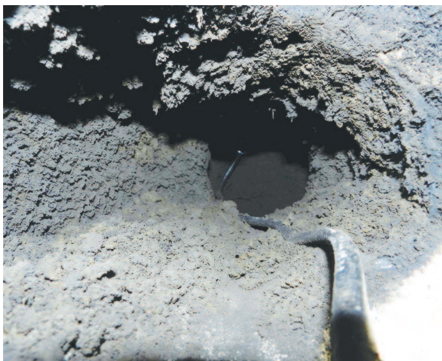
2. kép – Az eltömődött kémény endoszkópkamerás vizsgálat közben
