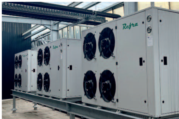
Három REFRA csoport-aggregát a tetőn, kettő a fagyasztókamra és egy a légszilip számára, valamint a normál hűtőkamra egy részére, a rendelések szállítása előtti tárolására
