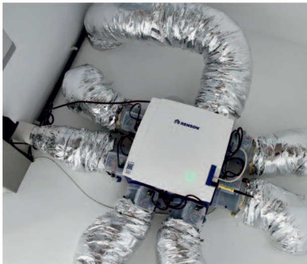
Renson központi szellőztető gép: Healthbox 3.0
