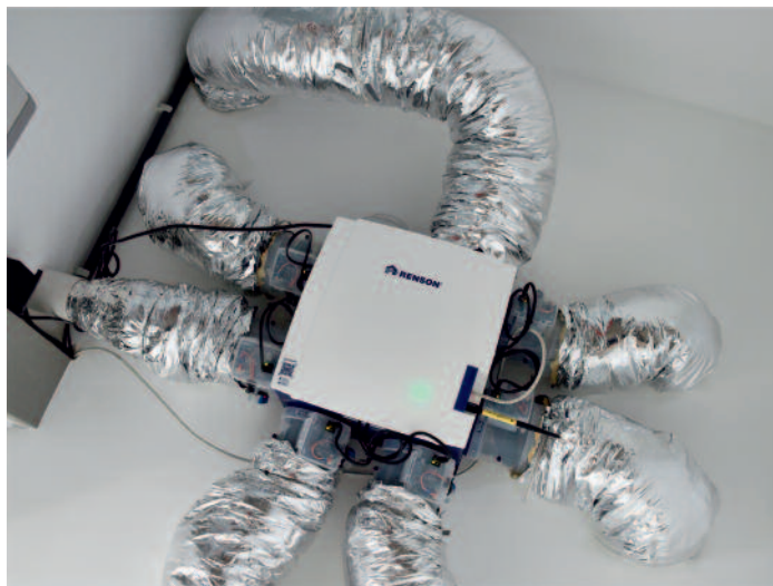
Renson központi szellőztető gép: Healthbox 3.0
