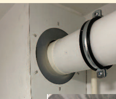
1. kép – Helytelen esővédelem. Az esővédő gallér nem fedi le a korábbi haszoncsövet, így az esővíz kifolyhat az induló szinten lévő lakásban
