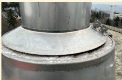
1. kép – Helytelen esővédelem. Az esővédő gallér nem fedi le a korábbi haszoncsövet, így az esővíz kifolyhat az induló szinten lévő lakásban
