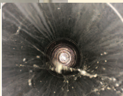
3. kép – Hozzáférhetetlen csappantyú. A csappantyúkkal felszerelt rendszerekhez ellenőrzés, karbantartás miatt hozzá kell férni. A képen látható esetben a fal által takart részen egy hosszabb, és iránytörést tartalmazó elem található a csappantyú előtt, ami szinte falbontást igényel a korrekt ellenőrzéshez, karbantartáshoz
