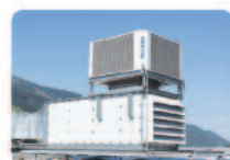
Modernizálás, HVAC retrofit
