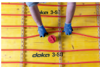
4. kép – Könnyű kikerülés, a cső a rögzítő-távtartó sínből felfelé egyszerűen kikapatható, pozíciója módosítható
