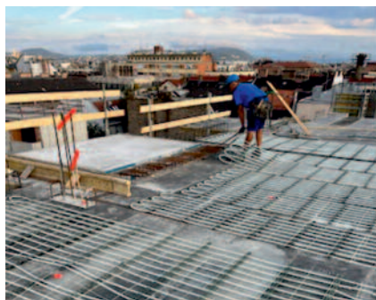
5. kép – Kemény munka lehetett ezt az egy helyszíni kikerülést megvalósítani a hálóra rögzített rendszerrel
