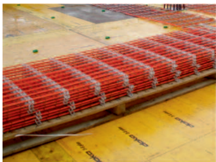
3. kép – Modulokban a gyárból az építkezésre szállítva – gyorsaság, gazdaságosság
