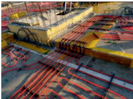
9. kép – Födém-szint-eltolás helyes követése a bebetonozandó csőrendszerrel, könyök-idomok
