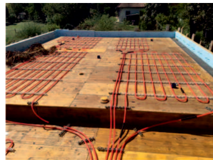
8. kép – A födém szint-eltolás helytelen következtése a hűtési csőrendszerrel
