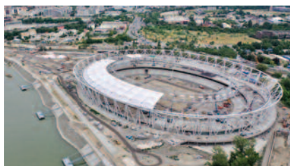
1. kép – Az atlétikai stadion elkészült vázszerkezete és az épülő kábelmembrán-szerkezet
