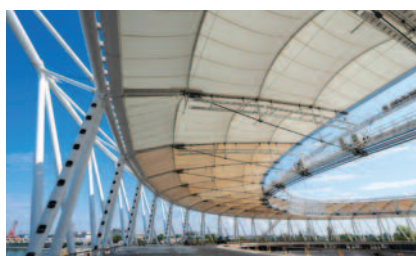
2. kép – A stadion kábelmembrán-szerkezetű fedése
