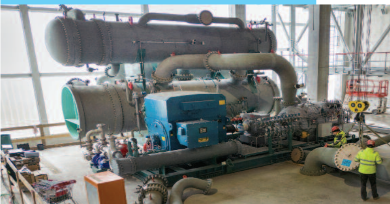
3. kép – A hőszivattyú szerelése (Copyright: Wien Energie)
